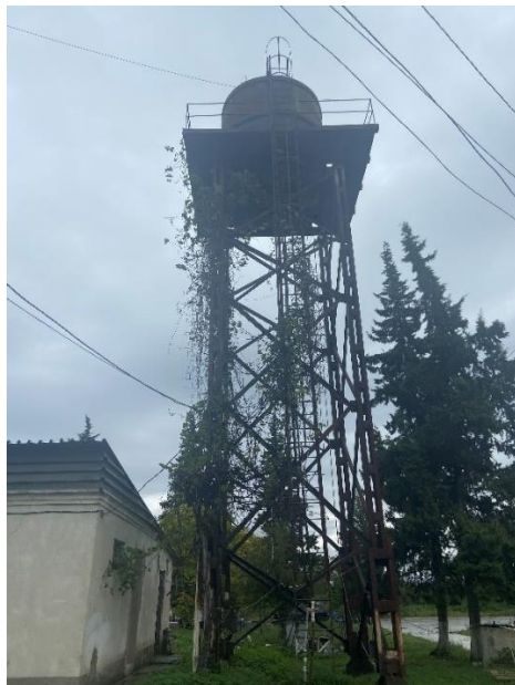
სურათი 7. წყლის რეზერვუარი, რომელიც განთავსებულია შენობის გარეთ და არ მუშავდება.
