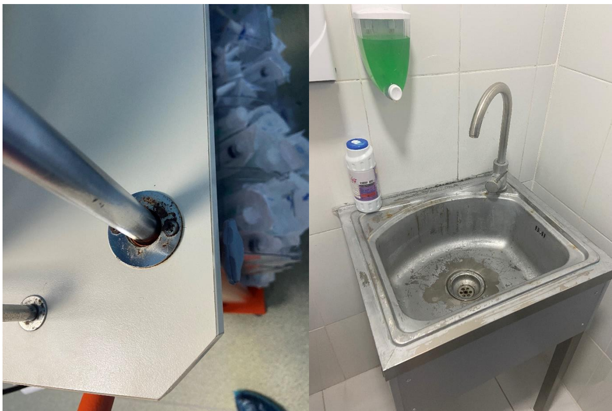
სურათი 11: დაზიანებული და კოროზირებული სამედიცინო ზედაპირები.
